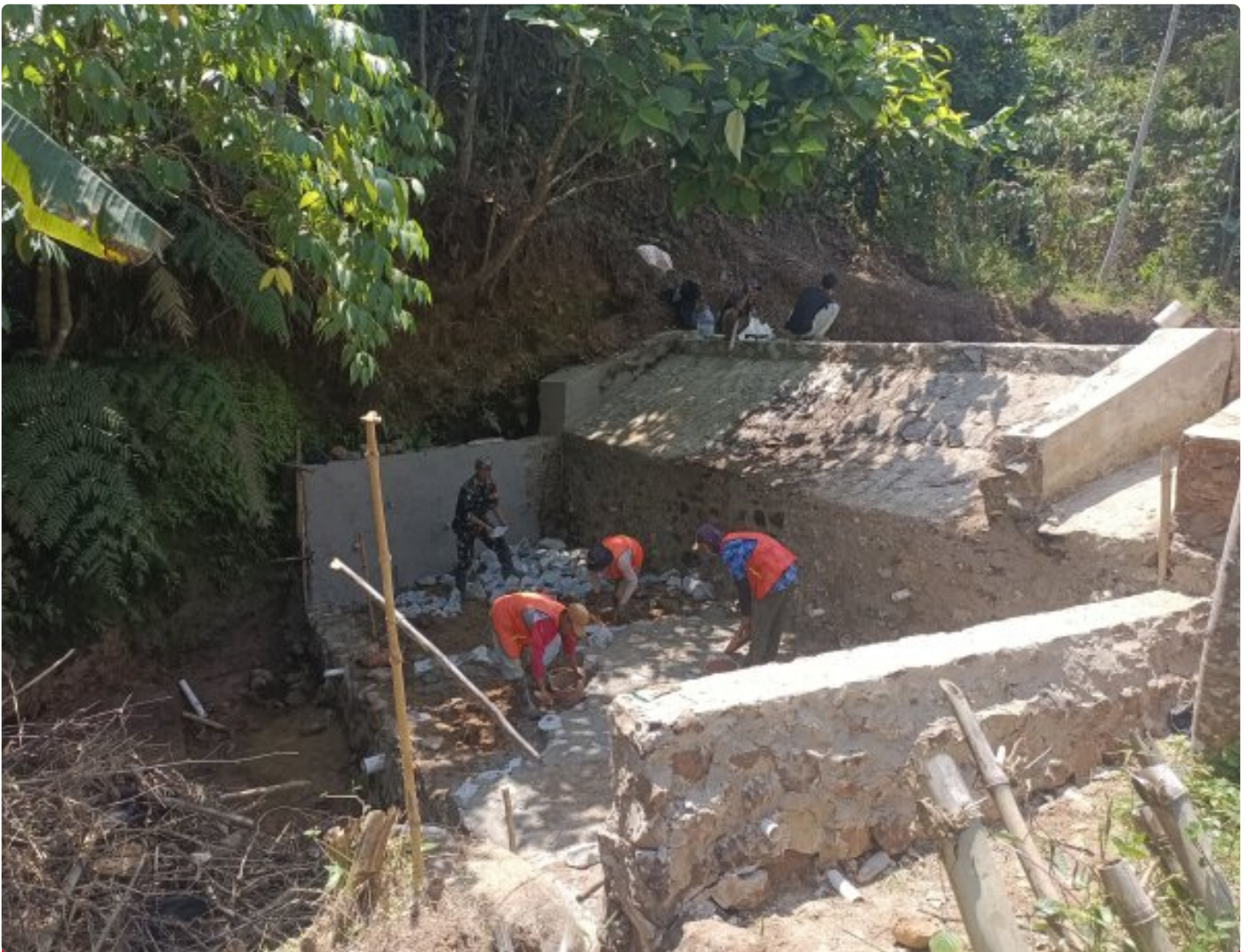
Babinsa tinjau pembangunan Bendung dan Irigasi
